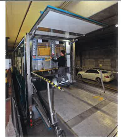
Dank vier Tonnen Hub und grosser Fläche werden jetzt gleichzeitig bis zu vier Rollbehälter angehoben.
